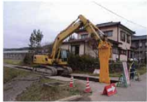
民家の近接部における改良施工
